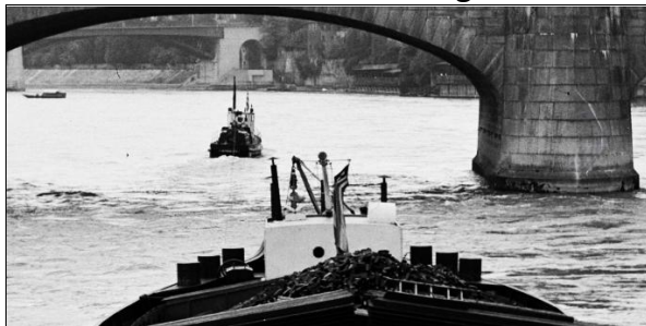
In der Mittleren Rheinbrücke
