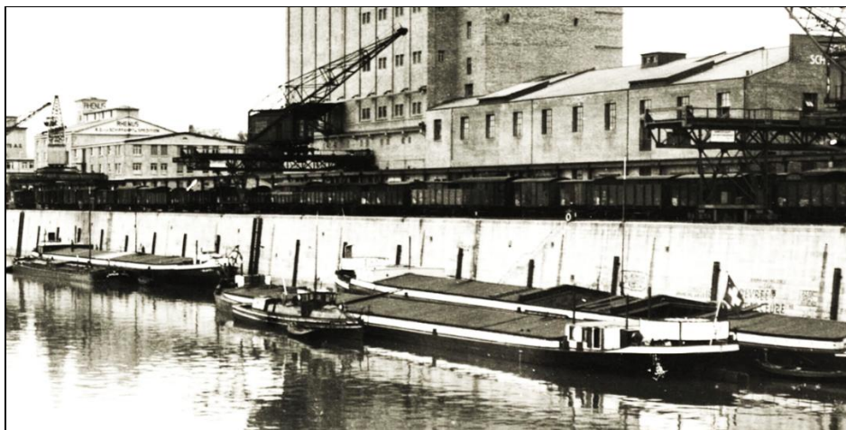
Blick ins Hafenbecken 1 mit dem neuen Bernoulli-Silo, ca. 1927. Im Vordergrund die «Unterwalden» neben einem Schleppschiff der «Buss-Serie» mit liegendem Haspel, der sogenannten «Nierenquetsche»
