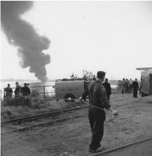
Vorbereitungen zum verladen der Tragkraftspritze
